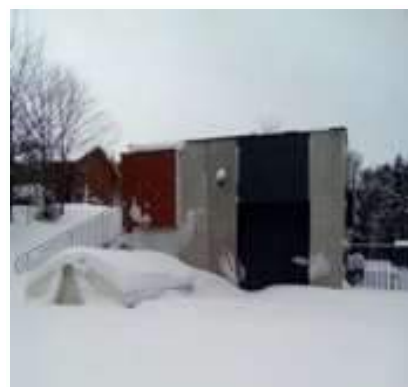
Station de traitement des eaux usées du Markstein (source CCRG).
