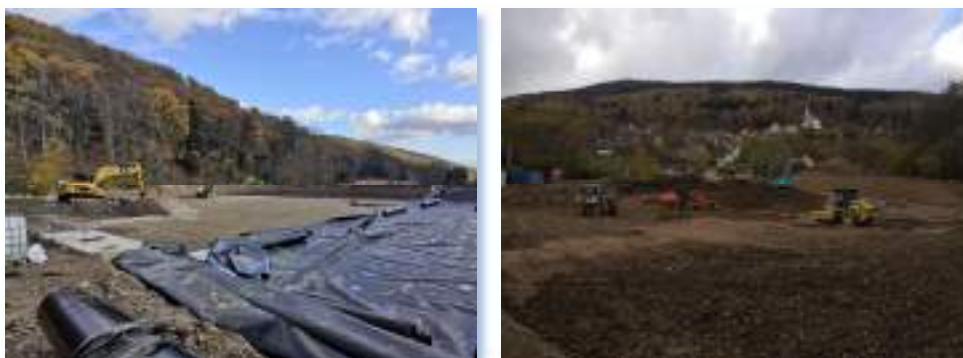
Aménagement du bassin d'eaux pluviales à Rimbach Zell.
