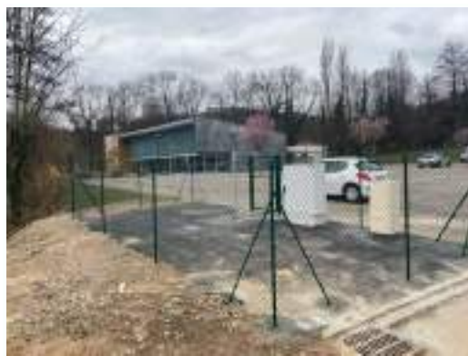
Station de relevage – Rue Latscha à Jungholtz.
