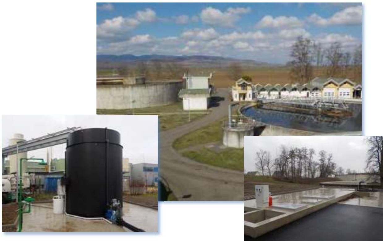
Station de traitement des eaux usées d'Issenheim (source CCRG).
